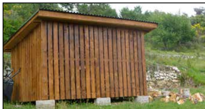
Travaux divers - Crédit : Paula et Dave Schulz
