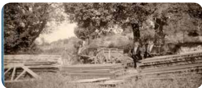
Le transport des éléments des baraques
