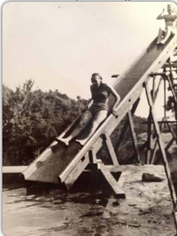
La nouvelle piscine avec toboggan
