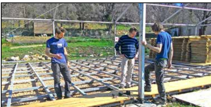
Montage du chapiteau en 2017 - Crédit : archives A Rocha
