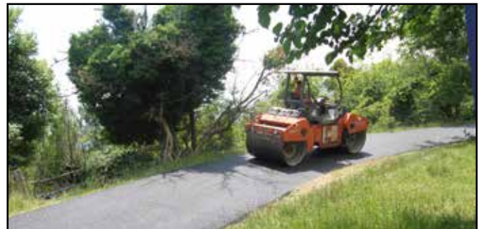
Cette route en cours de réfection en 2015
