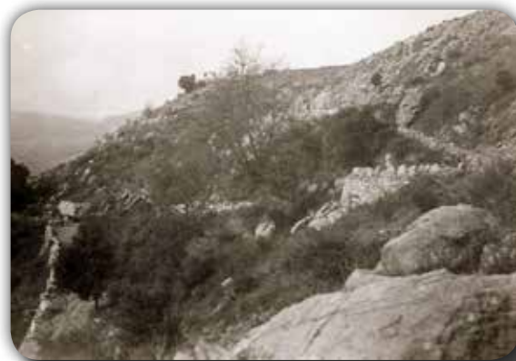
Le chemin d'accès difficilement praticable
