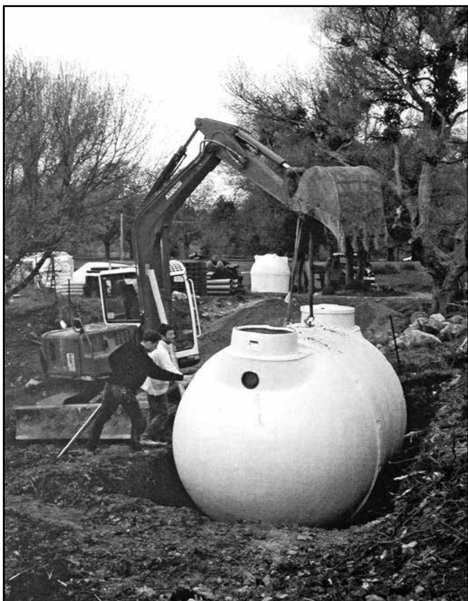
Installation de la station de traitement des eaux usées en 2002
